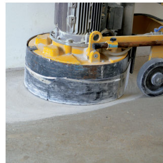
Pripremna brušenjem podloge
