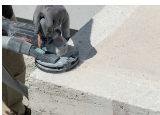
Pomoću ručne brusilice napraviti udubljenje
